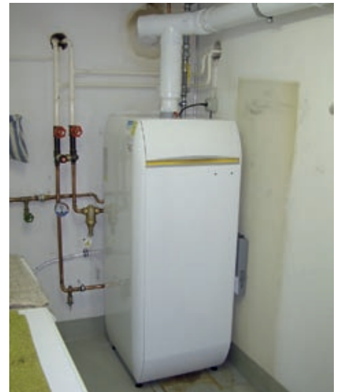
Kond. Gas-Heizkessel mit integriertem Wassererwärmer | Fabr. DeDietrich/Oertli
