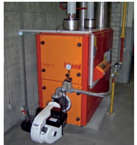
Ersatz best. Gasheizkessel, Gewerbeliegenschaft Fabr. Hoval, Typ Mega-3-600i, 600 kW
